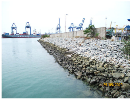
ภาพที่ 2.2-12 แนว REVETMENT บริเวณท่าเรือแหลมฉบัง
